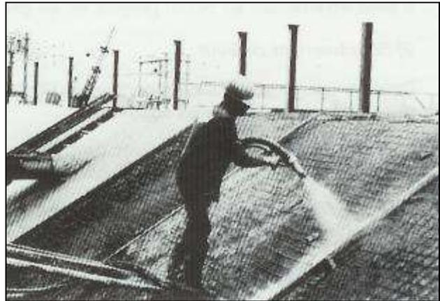
Fig 7.38 – Projection sur merlon de cuvette de rétention
